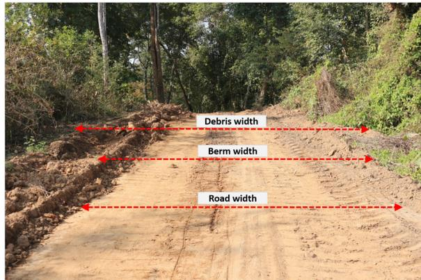
図3. 林道幅の計測
